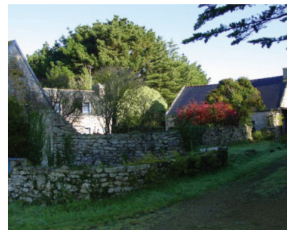
Bâti ancien : des habitats plus larges que hauts, usage de la pierre et de l'ardoise, toits pentus... Des pistes pour définir les caractères de l'architecture d'aujourd'hui.
